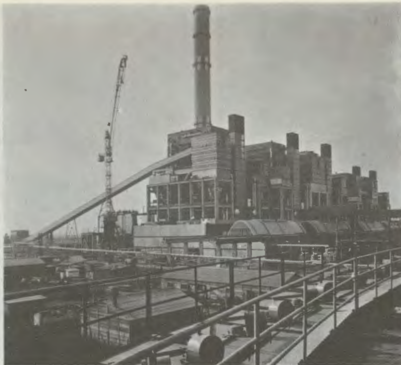
Gagarin Hőerőmű üzemi főépülete, Gyöngyösvisonta
